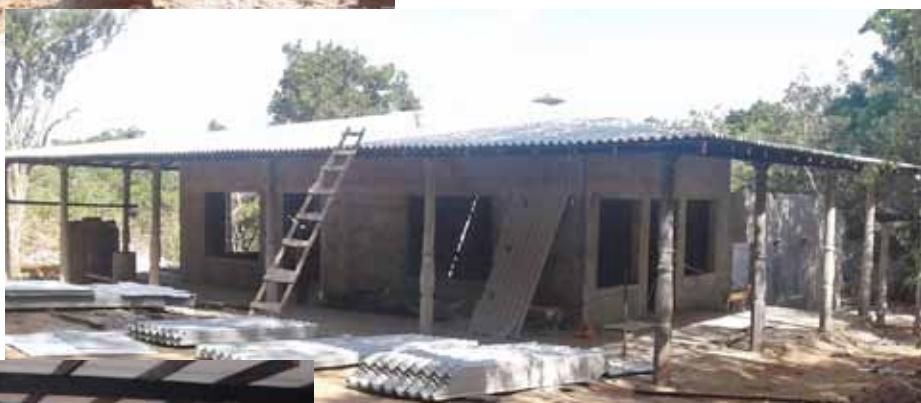
De muren van het hoofdgebouw staan en het dak is geplaatst. Er is nog veel werk te doen; de corridor moet nog worden aangelegd en het facilitaire gedeelte moet nog helemaal gebouwd worden.
