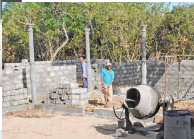
De aanleg van de corridor en de bouw het facilitaire gedeelte komt op gang.
