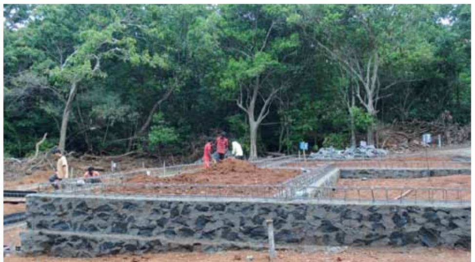
Februari was de fundering van het hoofdgebouw gelegd.
