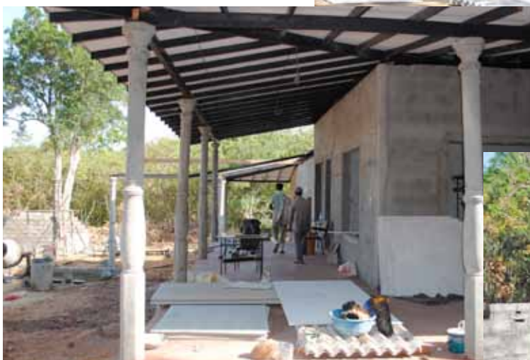
De linker zijkant waar de corridor nog aangebouwd moet worden.
