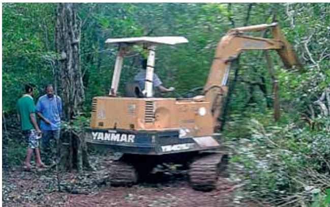
Met een speciale machine werden struiken en jonge bomen uit de grond getrokken om de weg aan te kunnen leggen.
