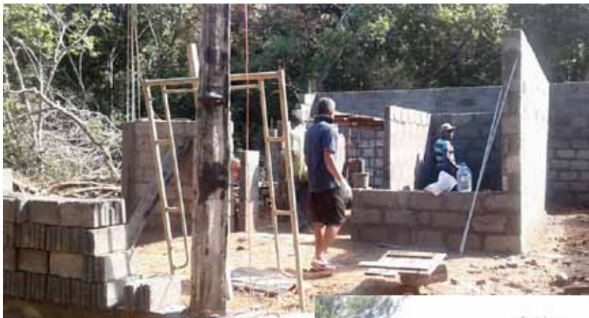
De muren van het hoofdgebouw worden op de fundering aangebracht.
